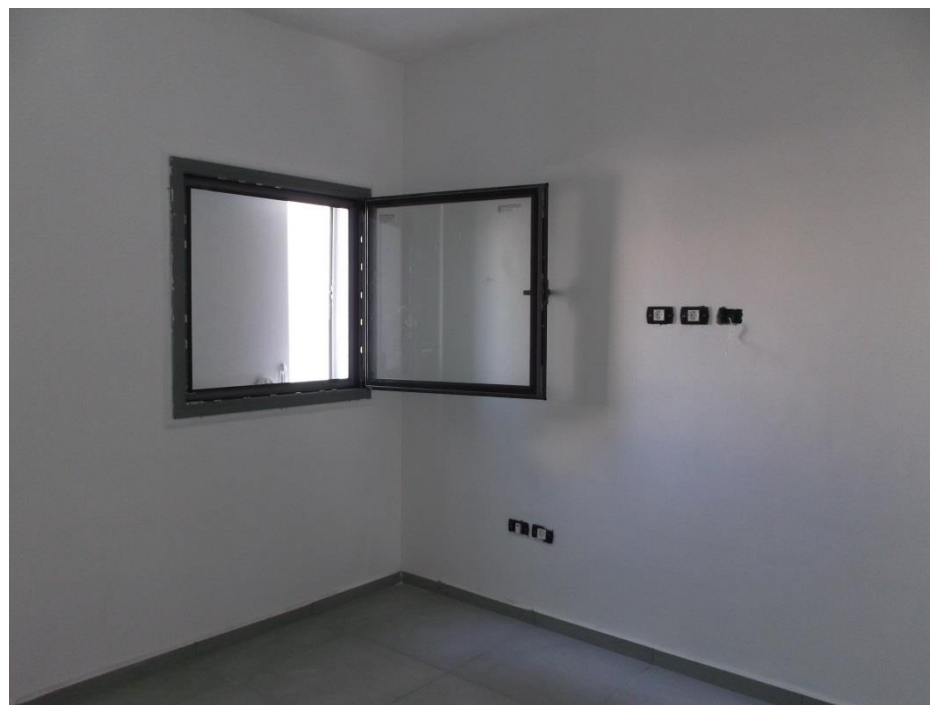
1. תמונה של החלון ומיקומו בחלל החדר (תמונה בזום רחב) יש להראות את החלון האטום מפני גזים ואת חלון ההגנה
